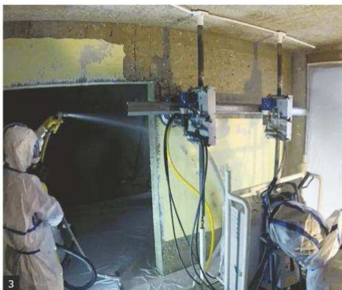
1 - Mis au point par SFTP, ce robot se repère dans une pièce et identifie les surfaces à poncer grâce à son laser 3D. 2 - Conçue pour poncer les colles amiantées au sol, Robotic Raboteuse devrait arriver sur le marché à l'été 2017. 3 - Adapté d'une table XY, ce système utilise une tête d'hydrodécapage robotisée et adaptable à différentes configurations. 4 - Cette ponceuse de colle au sol, au disque de 125 mm, est dédiée aux bordures des pièces.
